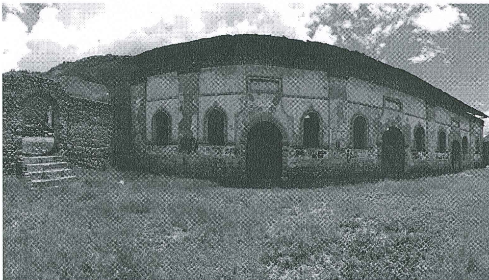
Vista panorámica de la ex casa hacienda de Patibamba
