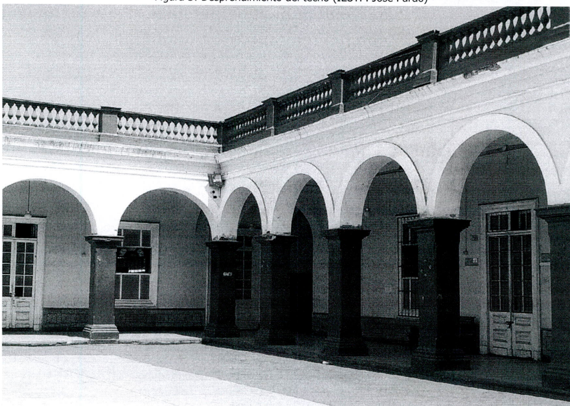
Figura 4: Arquitectura de arcos interna (IESTP. José Pardo)
