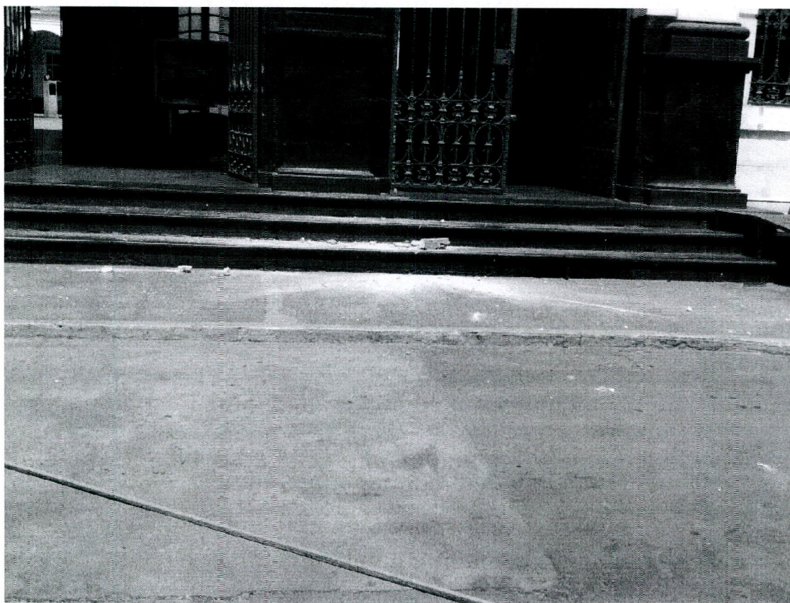
Figura 4: Desprendimiento del techo (IESTP. José Pardo)
