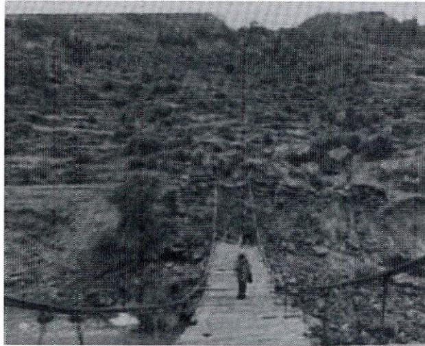
Puente Ccotachaca colgante apoyado en cimientos de mampostería de piedra colapsados
