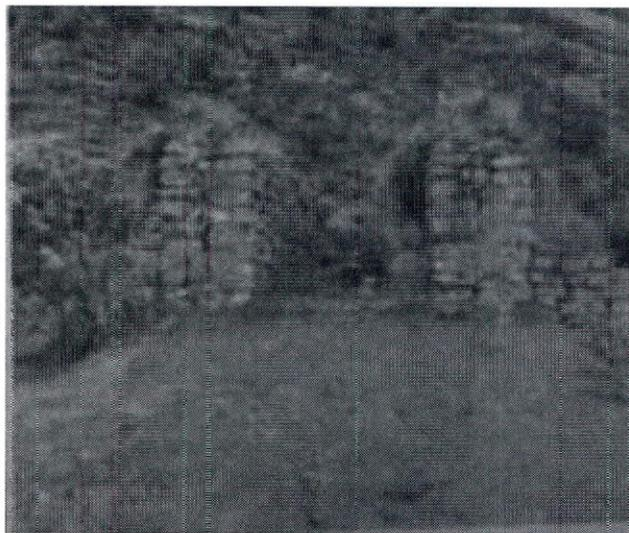
Apoyos del Puente edificados con mampostería de piedra labrada con mortero de cal y canto
