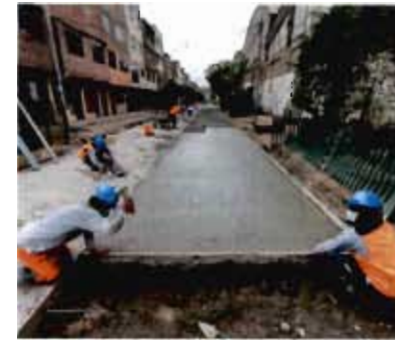
MEJORAMIENTO DE BARRIOS
