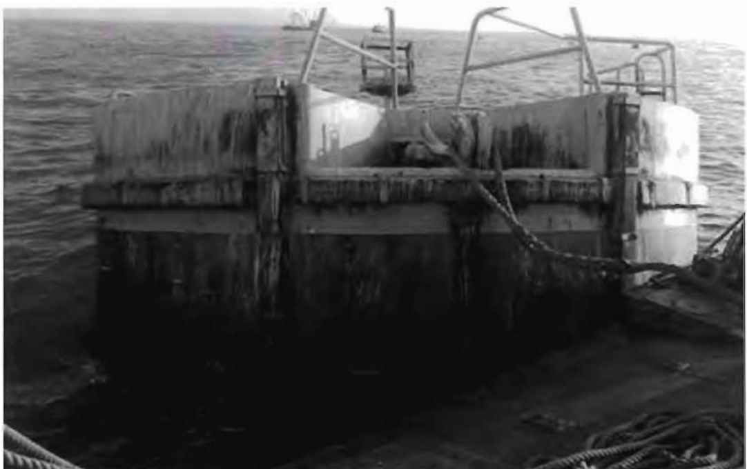
Figura 31. Boyarin sin mantenimiento del Terminal Portuario N°2
