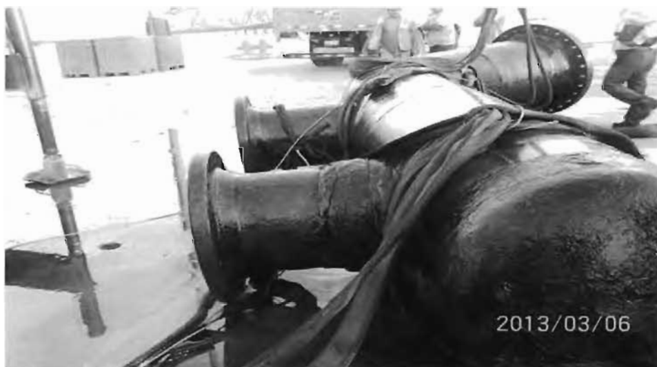
Figura 9. El agujero del PLEM por donde se habría producido el derrame en el año 2013
